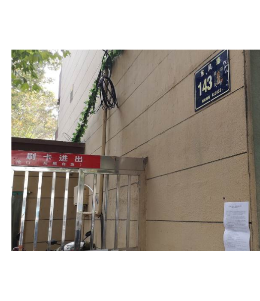
东风路 143 号院、星河家园
